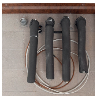
Esempio installazione con tubazioni dal pavimento
