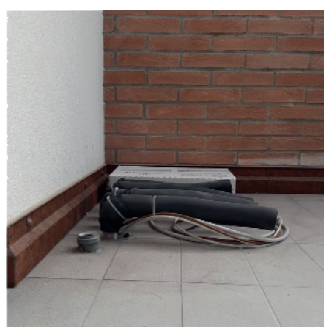
Esempio installazione con tubazioni dal pavimento
